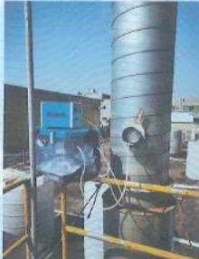
有机废气处理后检测口
